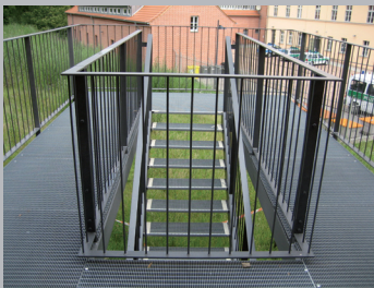
2007 - Neubau der Treppenanlage vor dem Nordtor (Wiederherstellung der historischen Wegebeziehung zum Ortskern).
