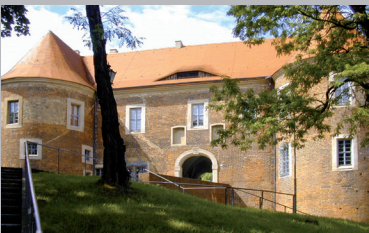
Torhaus Burg Eisenhardt nach der Sanierung.
