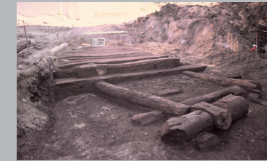
Blick auf die starke Unterkonstruktion des mehrlagigen Bohlenweges zur Hauptburg (Grabung Polizeigelände).
