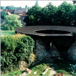
1994 - Die Zisterne und Teile der Ringmauer vor der Sanierung.
