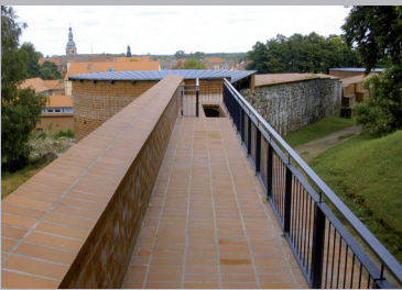
Sanierte Ringmauer - Erneuerung der Nord-Bastion mit Verbindungsweg auf der Mauer (Wehrgang) zwischen Nord- und Nord-West-Bastion.
