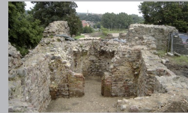
Blick in die ausgeschachtete romanische Kapelle mit ihrem einstigen Fußbodenniveau (Grabung Burg).
