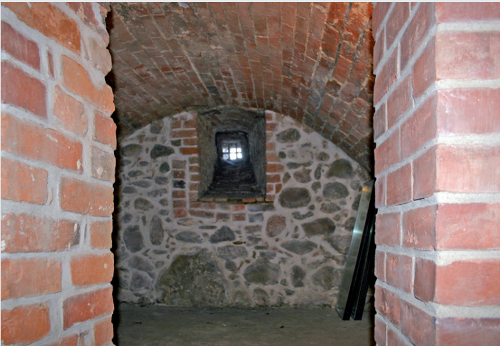
Aufnahme des denkmalgeschützten Kellerraumes
