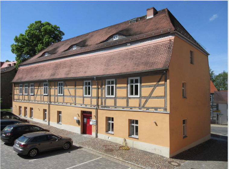
Vorbildlich sanierte Hoffassade mit freigelegtem Fachwerk, 2019
