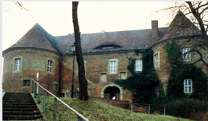
Torhaus der Burganlage vor der Sanierung, Aufnahme 1991
